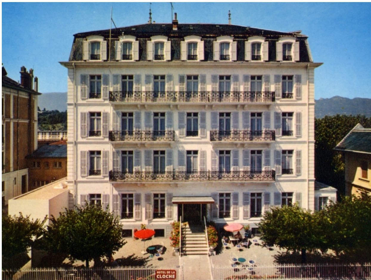
Façade sur l'avenue Marie-de-Solms
