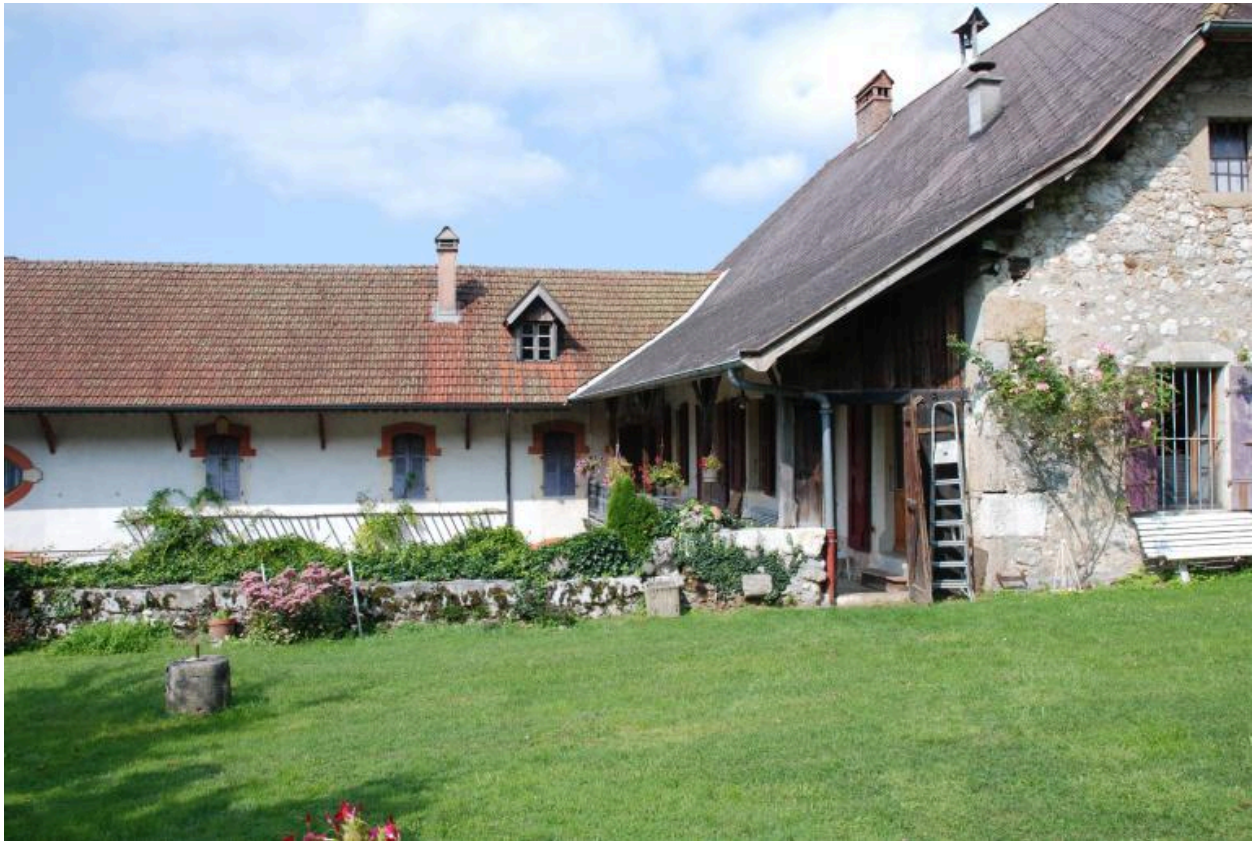
Vue d'ensemble du deuxième niveau des corps de bâtiments sur cour.
