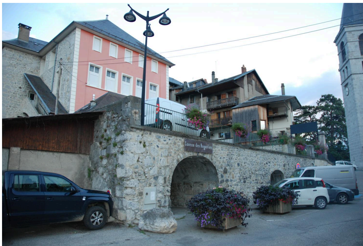
Vue générale du site depuis le sud-ouest.
