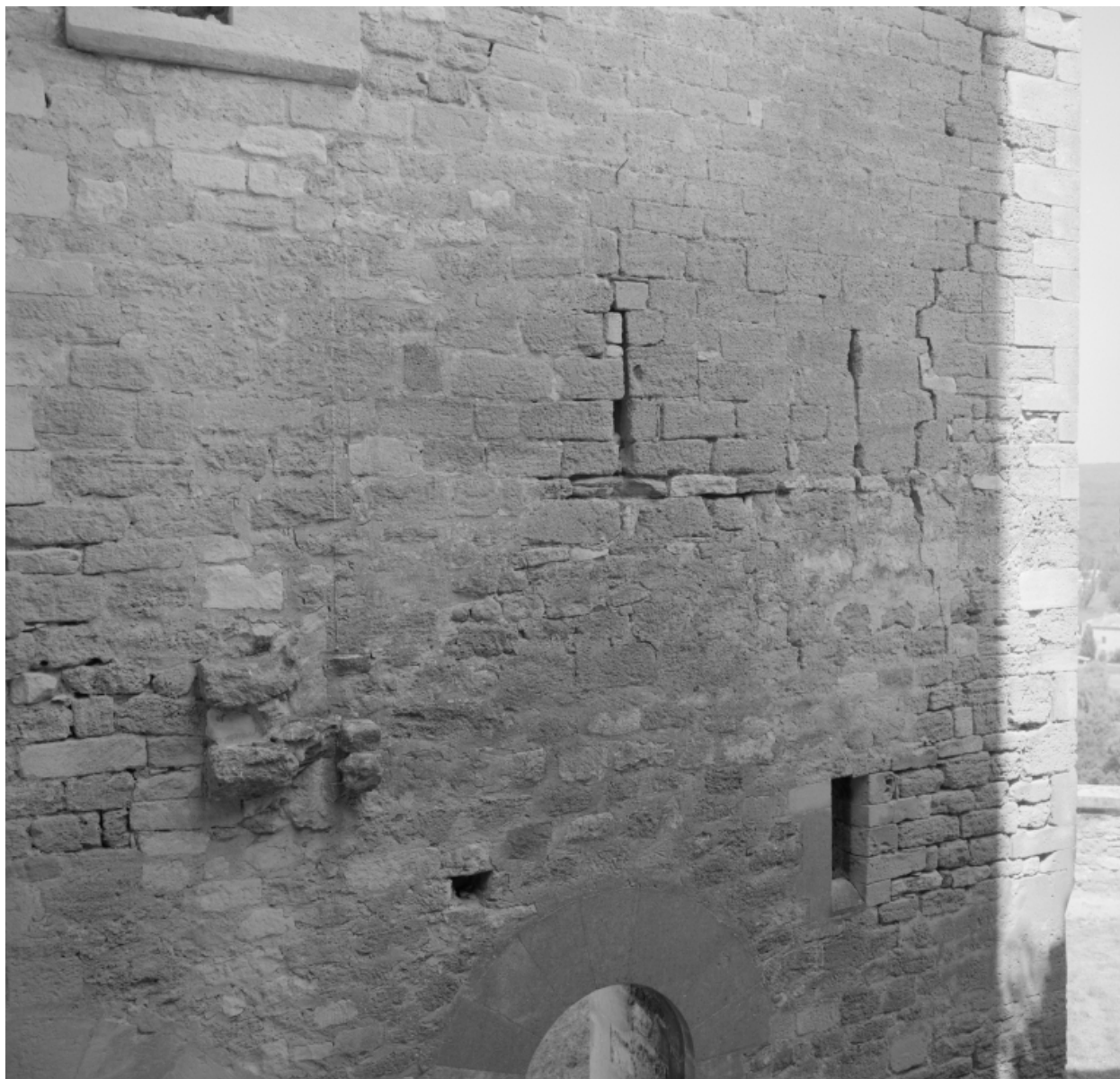
Bâtiment ouest, parties hautes du mur nord.
