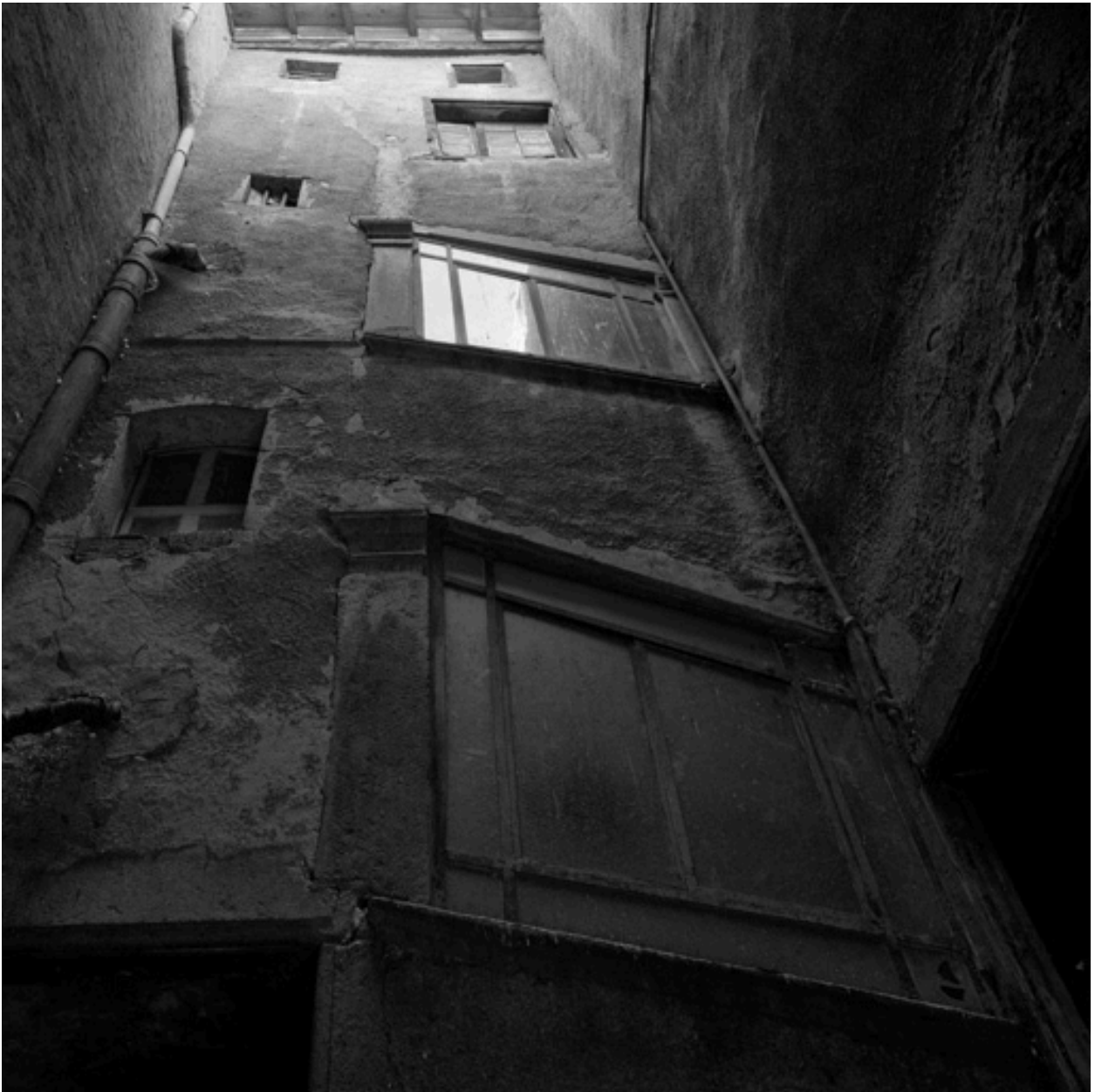
Cage d'escalier ouverte donnant sur un puits de lumière.
