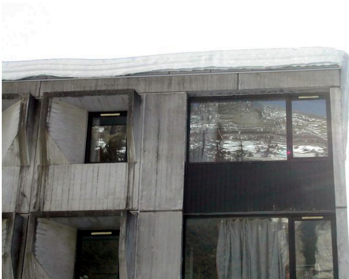
Etat avant réfection. Façade nord. Détail des baies de l'angle nord-ouest
