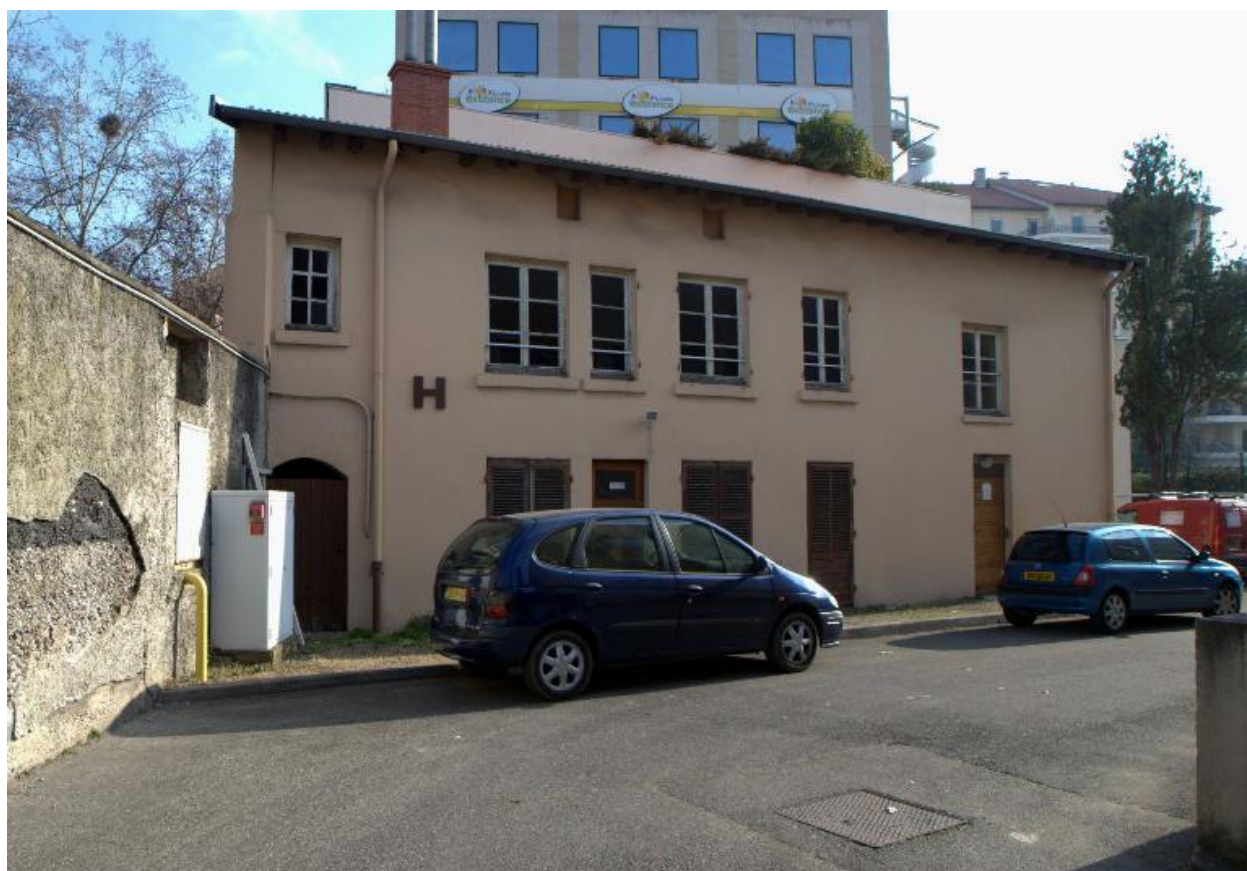
Bâtiment H, élévation principale
