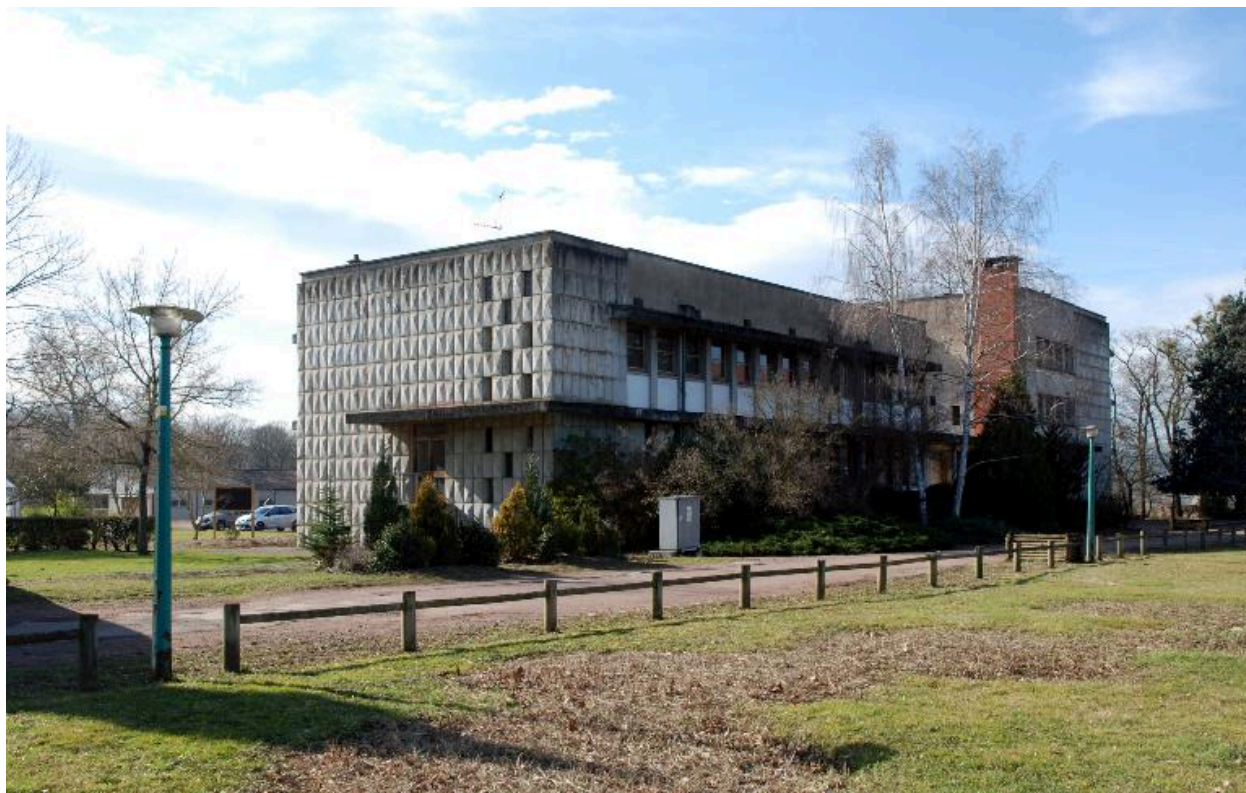
Bâtiment B, vue d'ensemble depuis l'est
