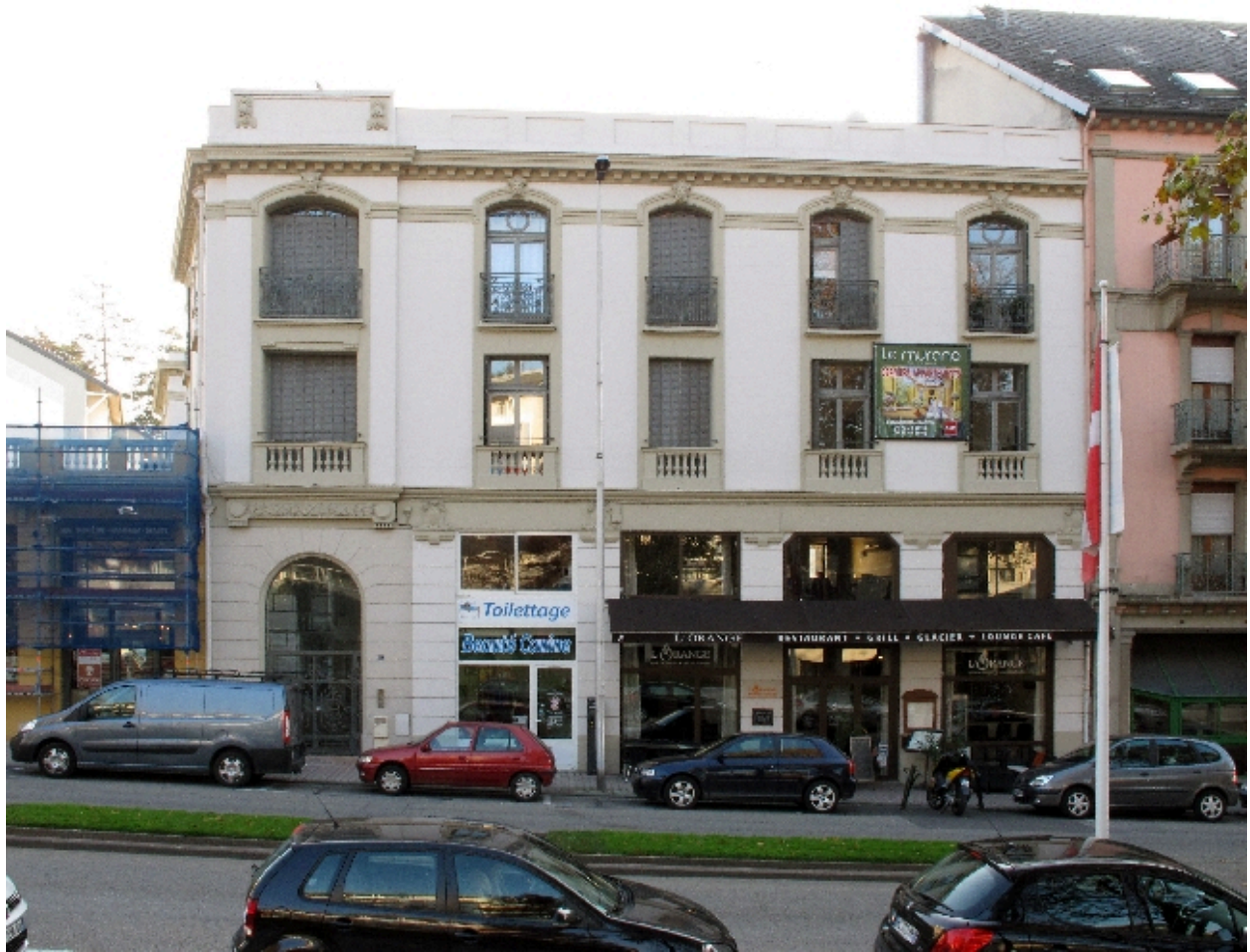
Façade principale de l'ancien hôtel
