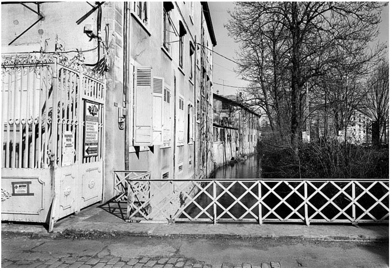
Entrée principale sud, pont sur la rivière le Morgon
