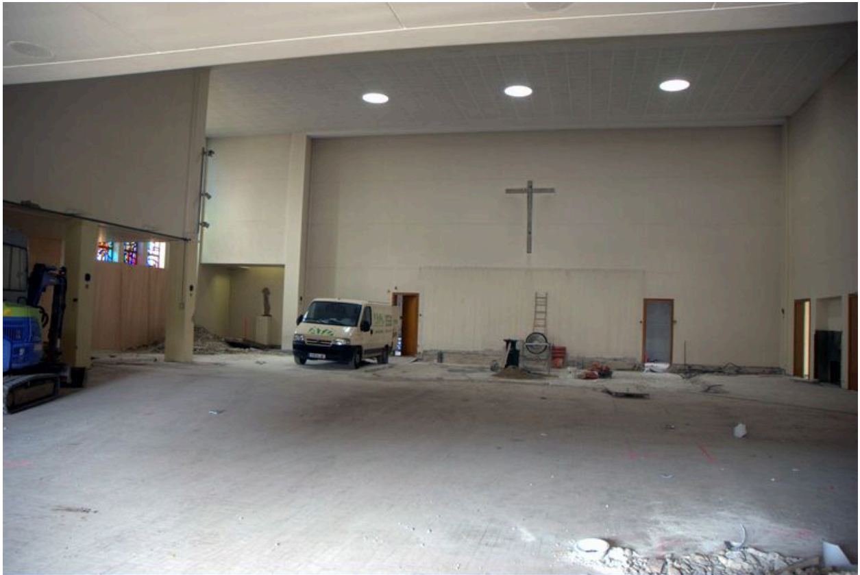
Intérieur de l'église depuis l'est, chantier en cours, mai 2008
