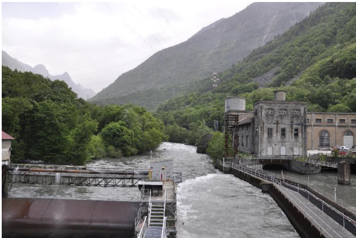
Vue des bâtiments de la centrale et la Romanche
