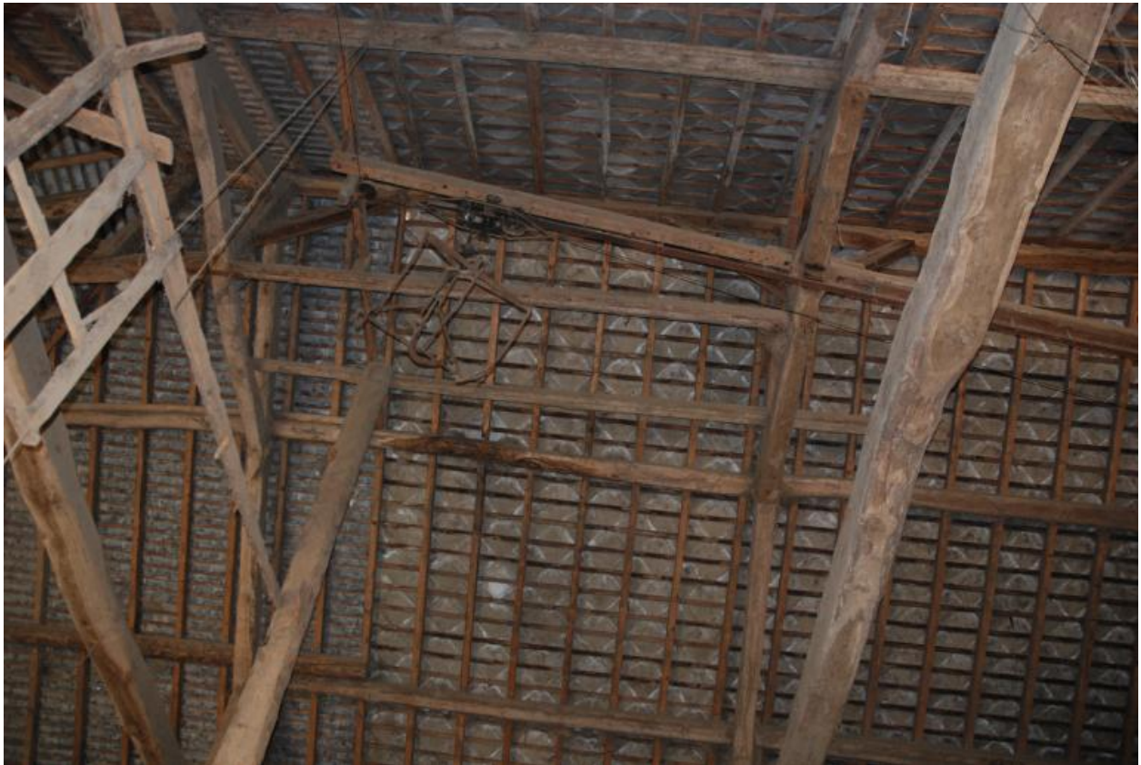
Vue intérieure de la grange : griffe à foin.
