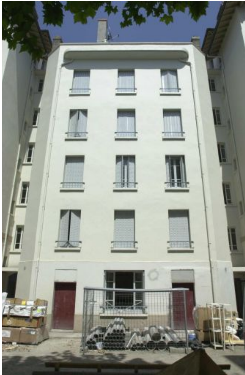
Elévation sud sur cour, pendant les travaux de 2001
