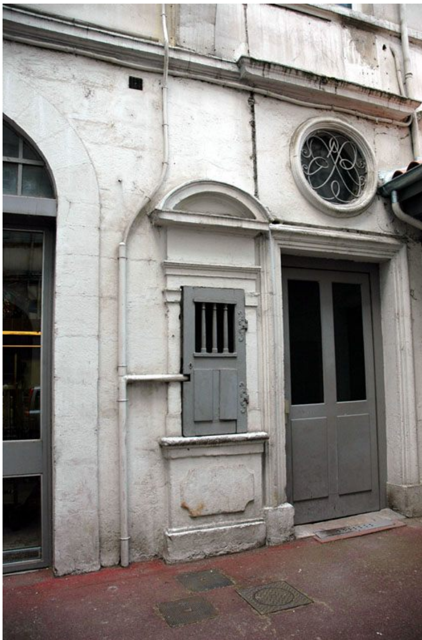
La cour, élévation sud : le puits
