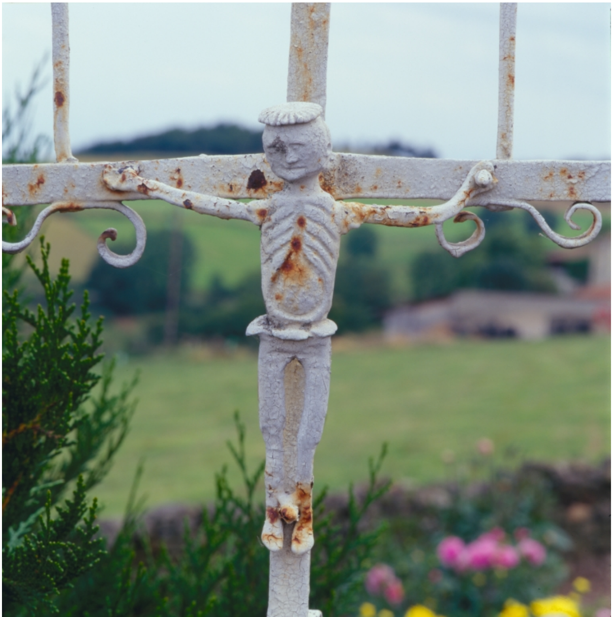
Détail de la partie supérieure du croisillon.
