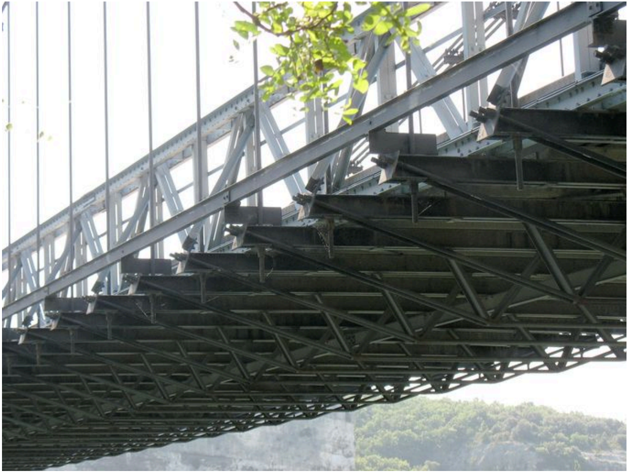
Dessous du tablier : vue partielle
