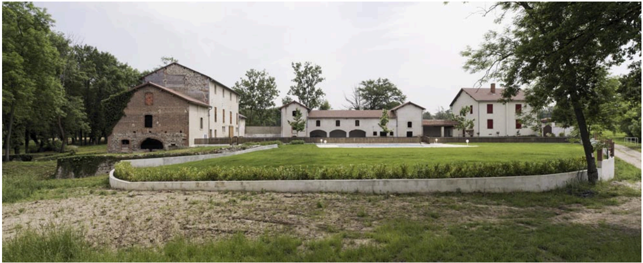
Vue générale, depuis le sud-ouest.
