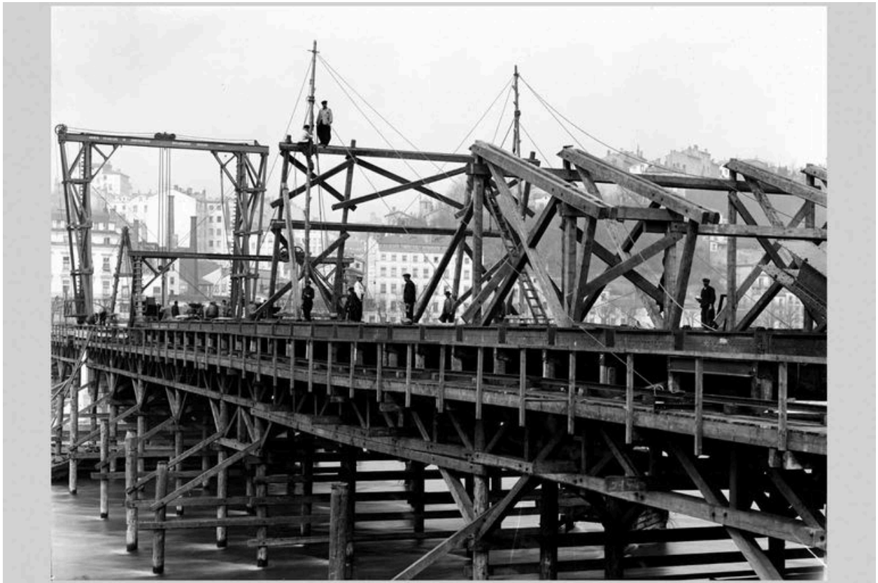
La construction du pont de la Boucle. La construction des arches supérieures. Photogr., [1903] (Arch. mun. Lyon. 15 Ph 1812)
