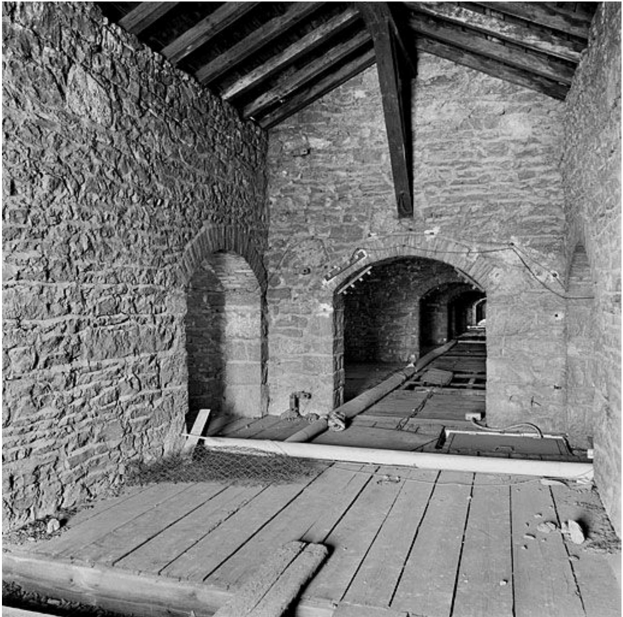
Caserne: Vue des combles
