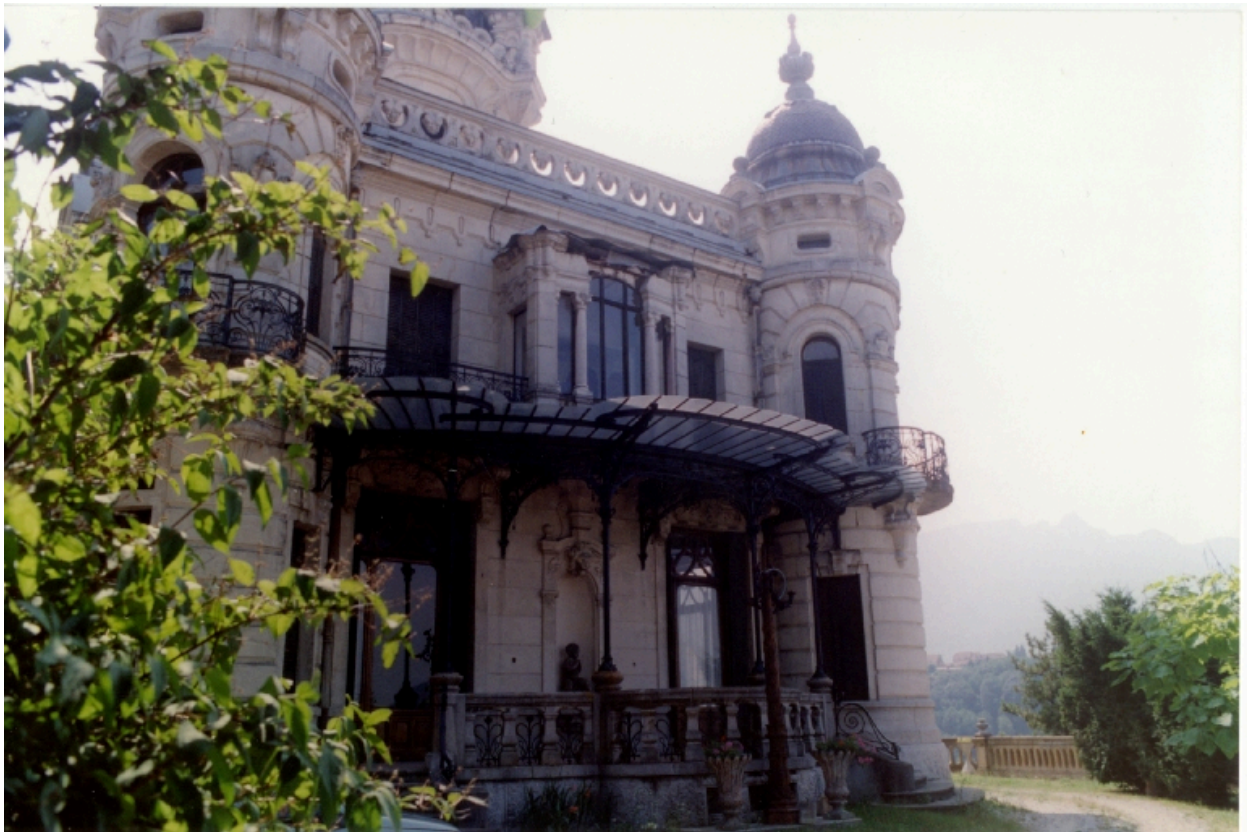
Façade latérale nord
