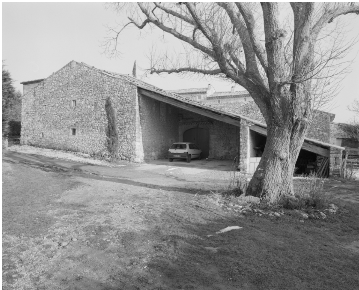
L'entrée de la cour, sous l'appentis.
