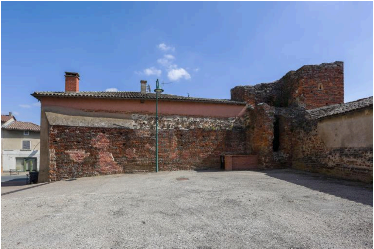
La tour sud-est.
