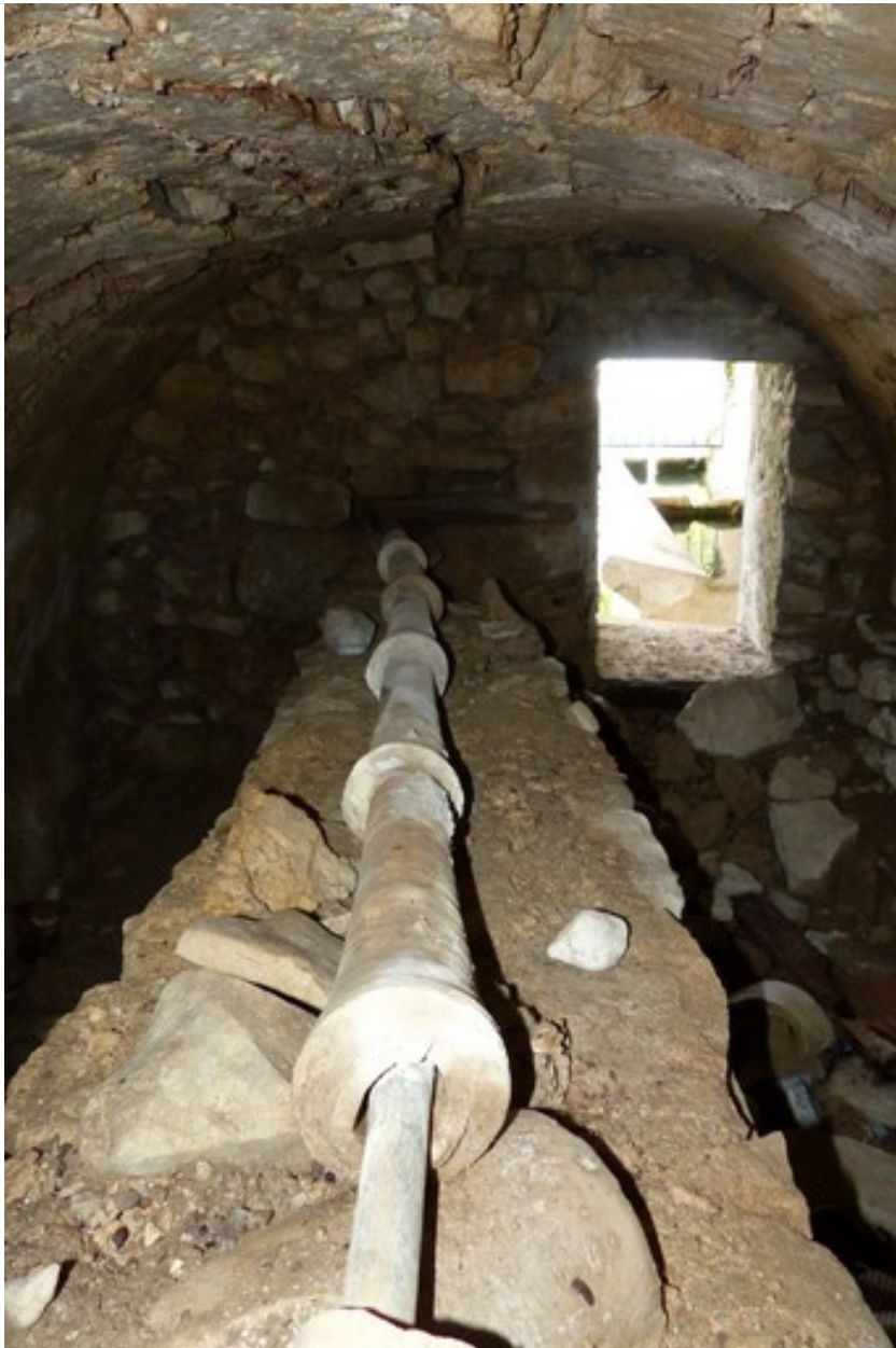
Réservoir. Passage de la canalisation en terre cuite.
