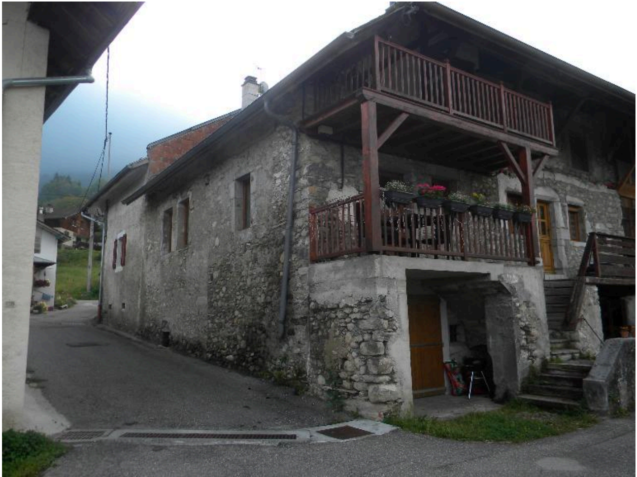
Vue de la façade nord.
