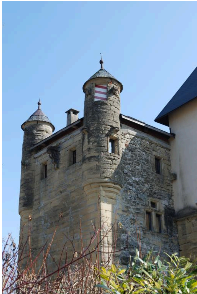
Partie haute des façades ouest et sud de la maison forte.
