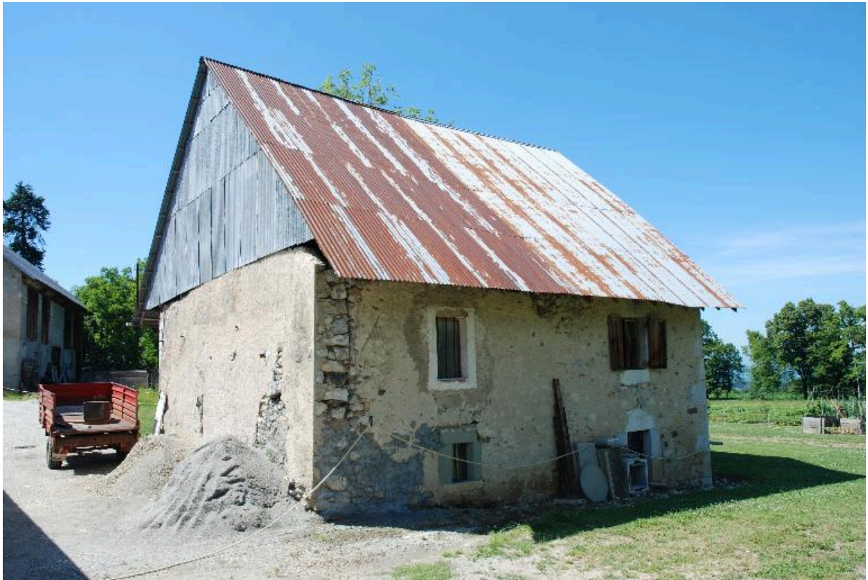
Habitation (2014 A1 1405, partie nord), non repérée : vue arrière.
