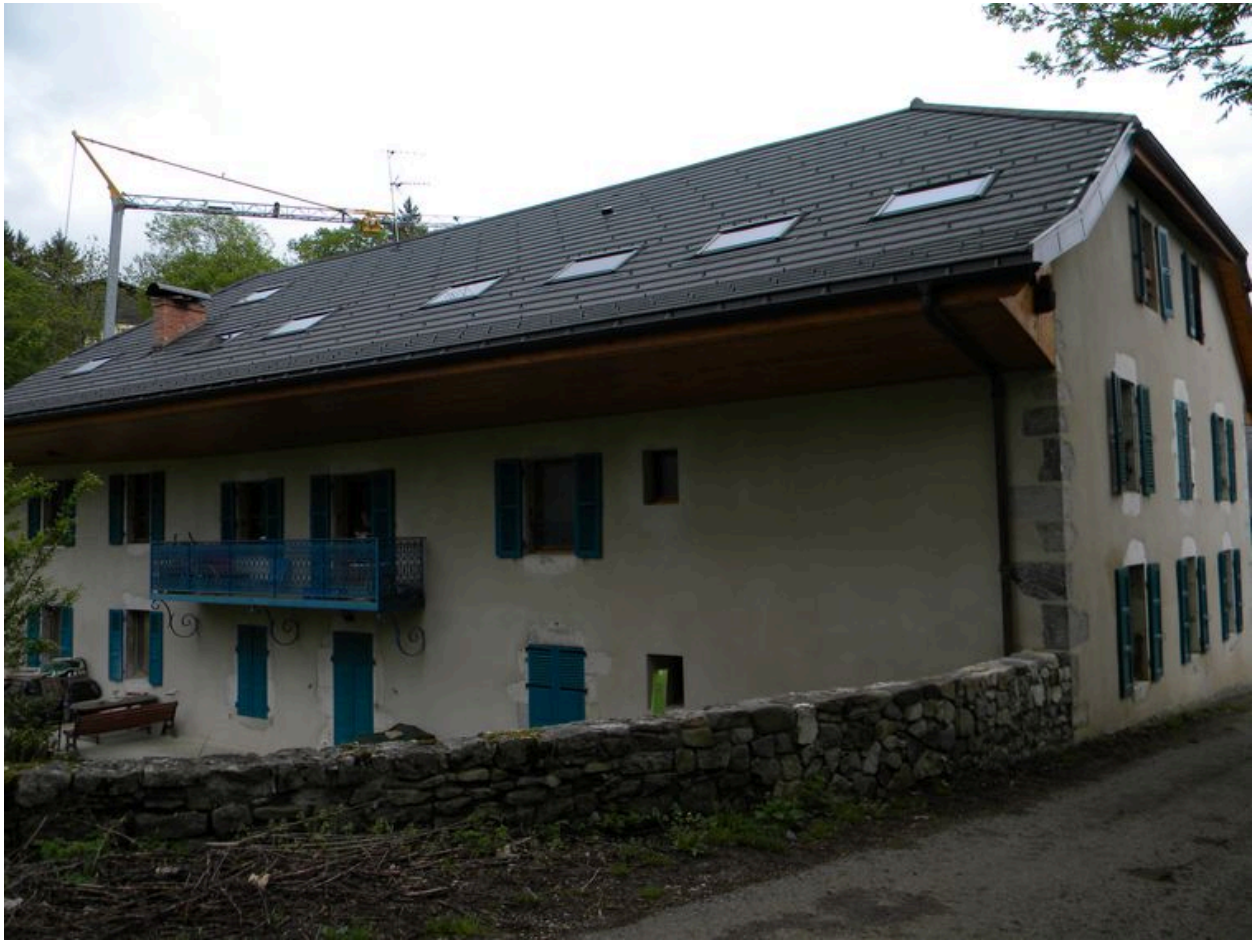
Vue générale de la maison depuis le sud.
