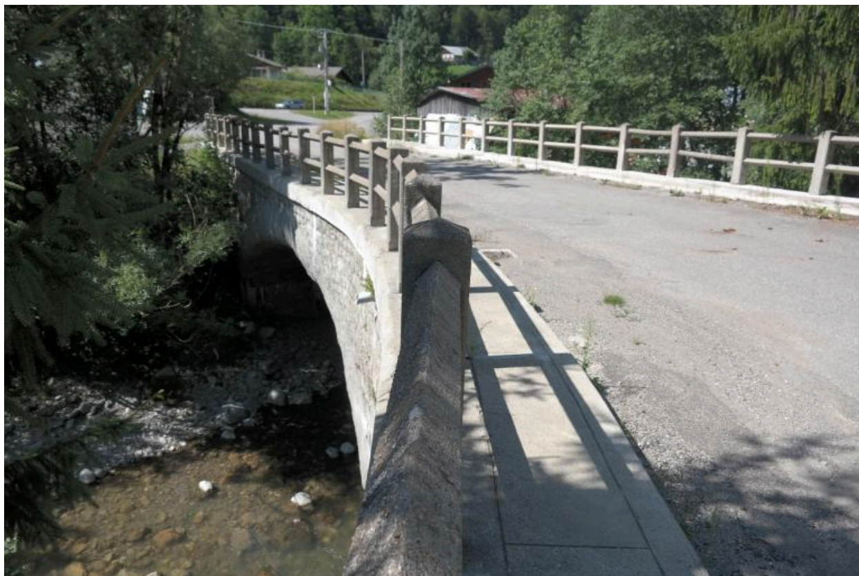
Vue générale du Pont de la Solitude
