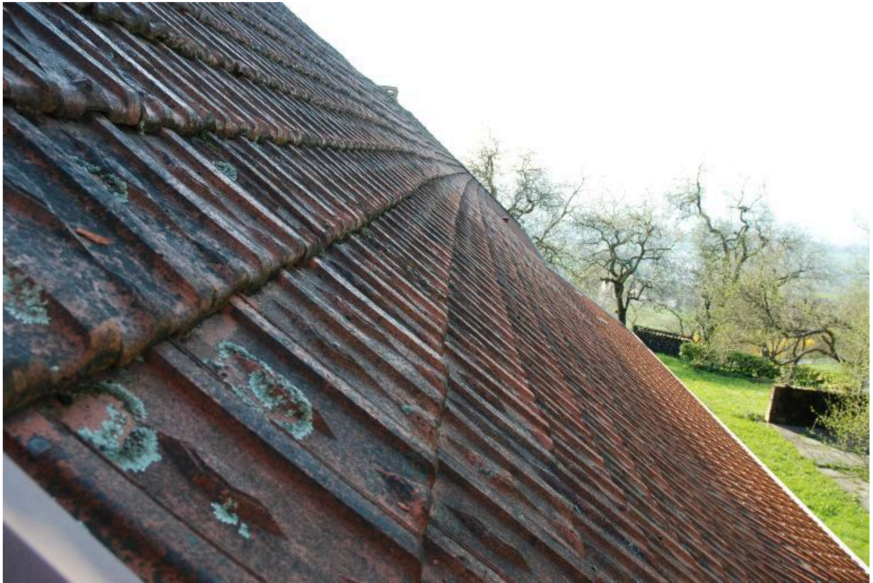
Détail du toit.
