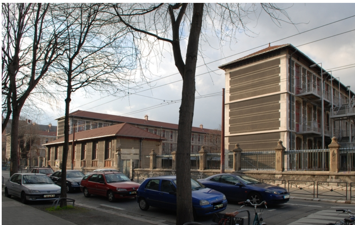
Bâtiments 'en dent de peigne' sur la rue Lesdiguières, depuis le sud-ouest
