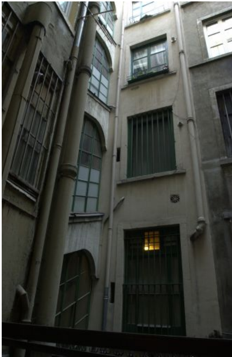
Elévations sur cour, vue prise depuis l'escalier de l'immeuble 8, rue de la Poulallerie
