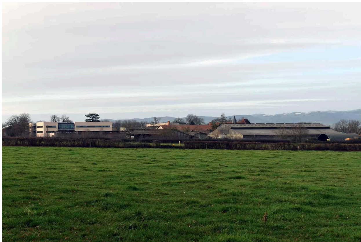
Vue d'ensemble depuis le nord-est avec le nouveau bâtiment d'enseignement
