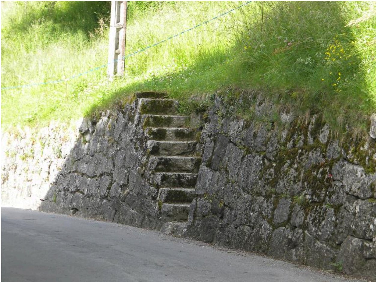
Détail d'escalier dans un mur le long de la route.
