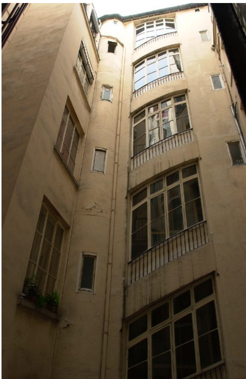
Cage d'escalier sur cour
