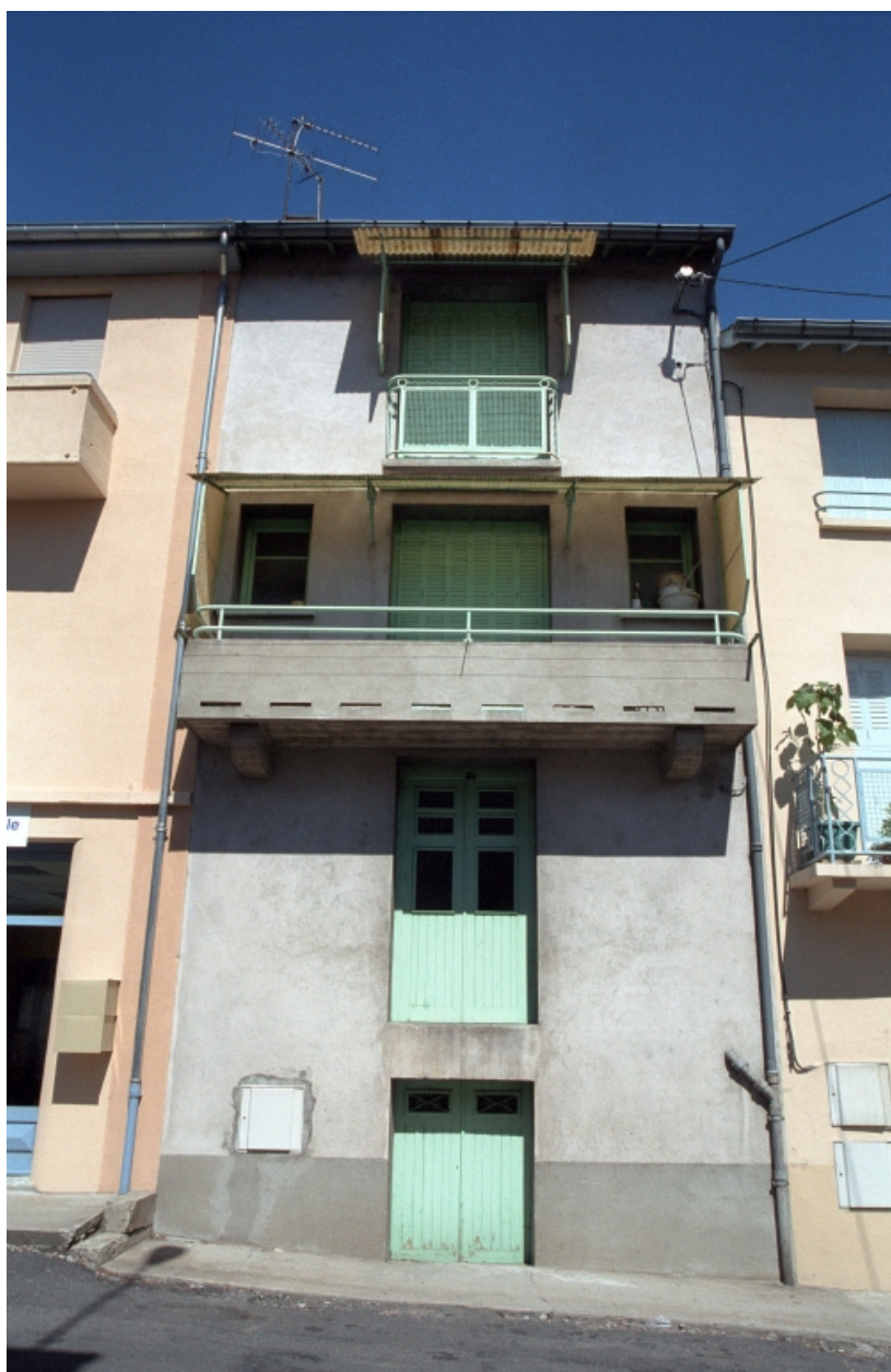
Boën, îlot 14, Gustave Labrosse (rue) 8. Vue générale de la façade sur rue.
