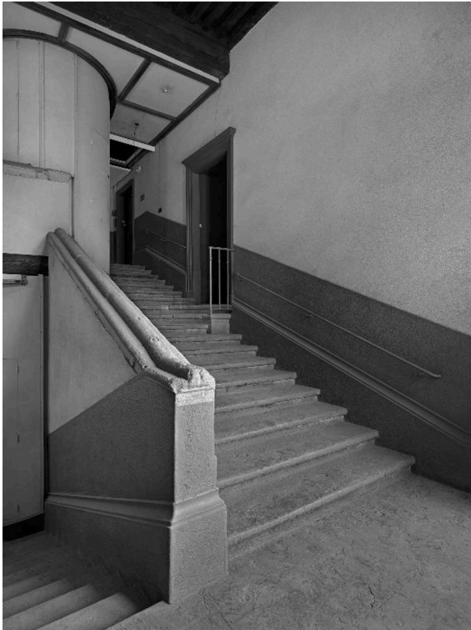
L'escalier ouest : dernière volée
