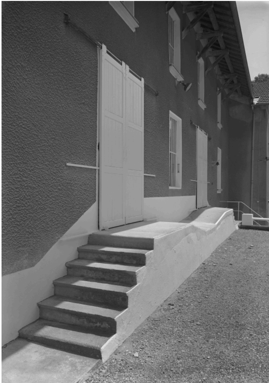
Quai de chargement.
