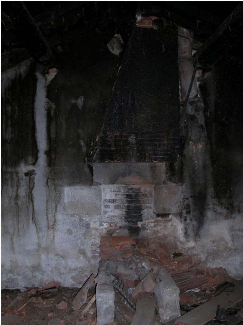
Vue intérieure du fournil.
