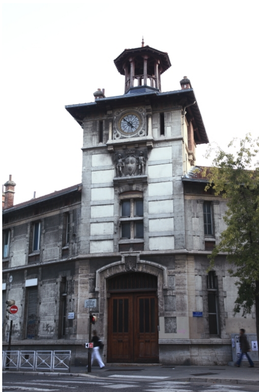
Petit lycée. Pavillon d'entrée.
