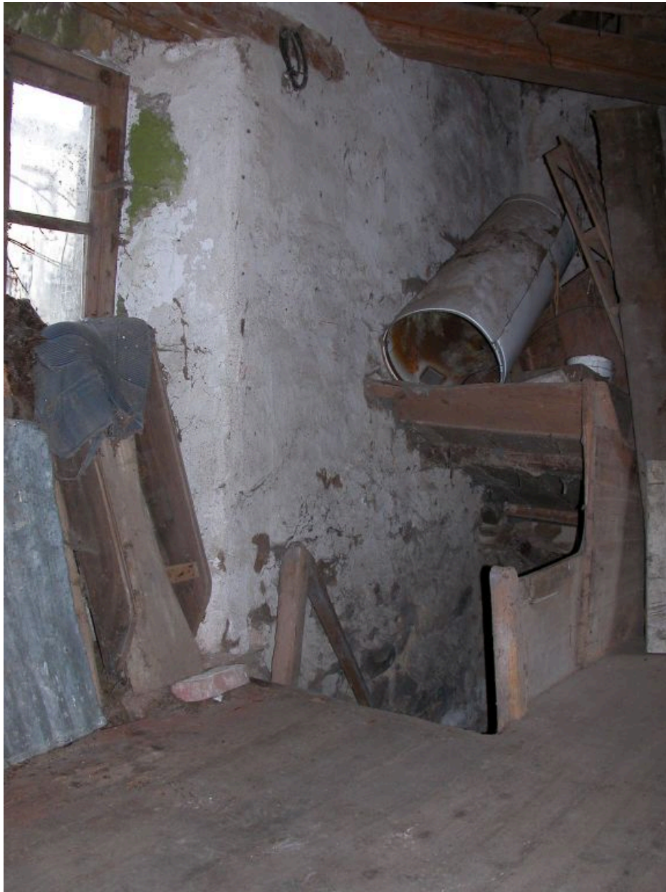
Rez-de-chaussée surélevé, débouché de l'escalier.
