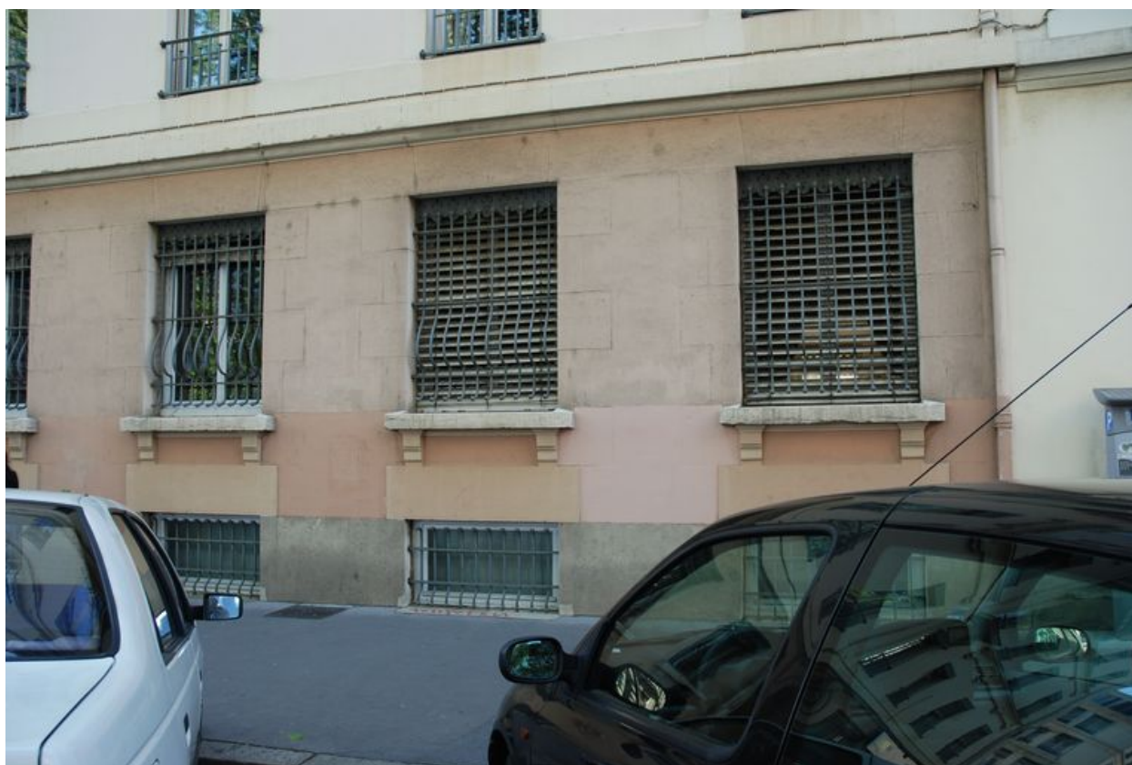
Détail du rez-de-chaussée, rue Cavenne
