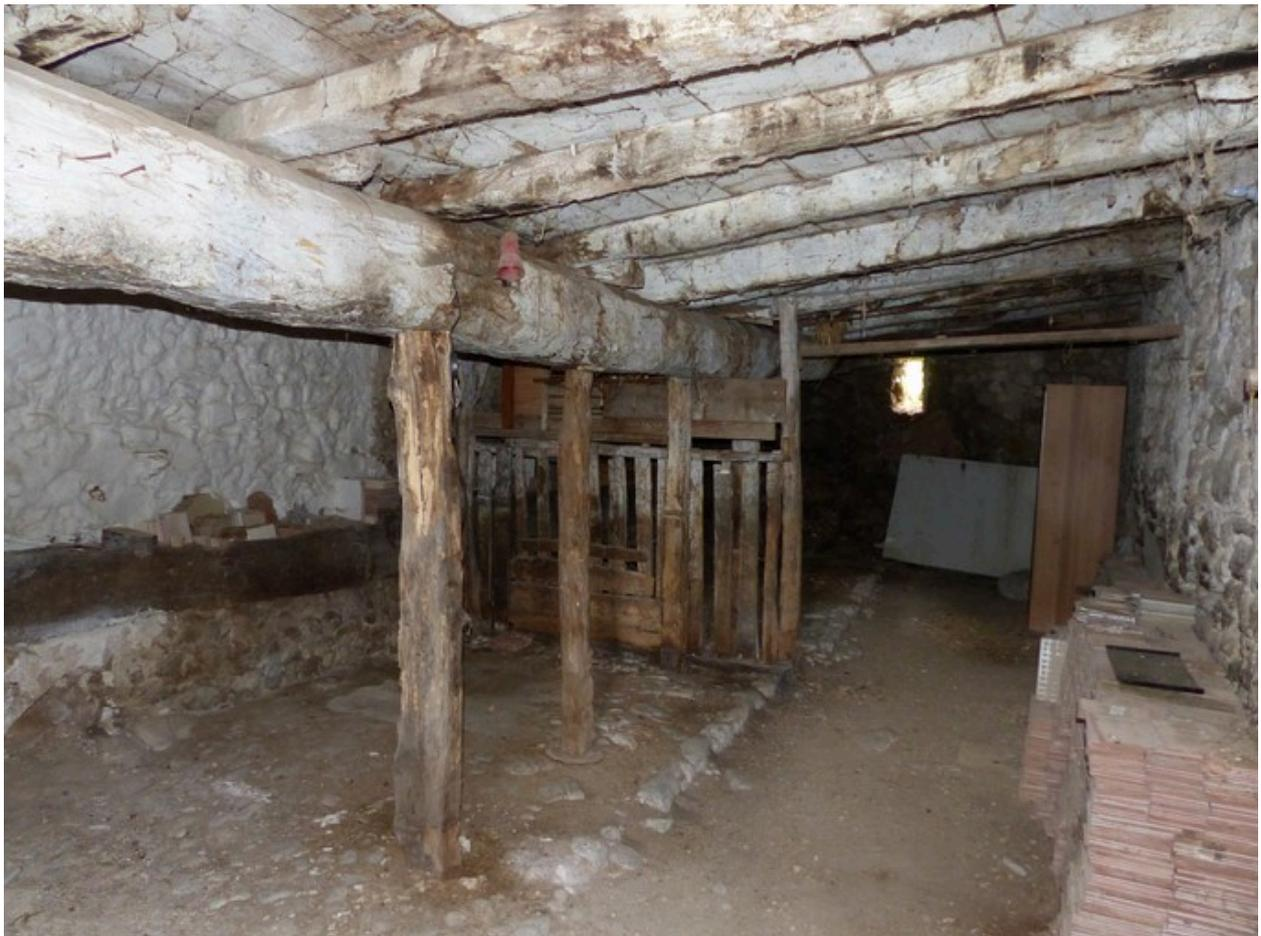
Etable en étage de soubassement, couverte par un plancher. Ferme au quartier de Bigonnet.
