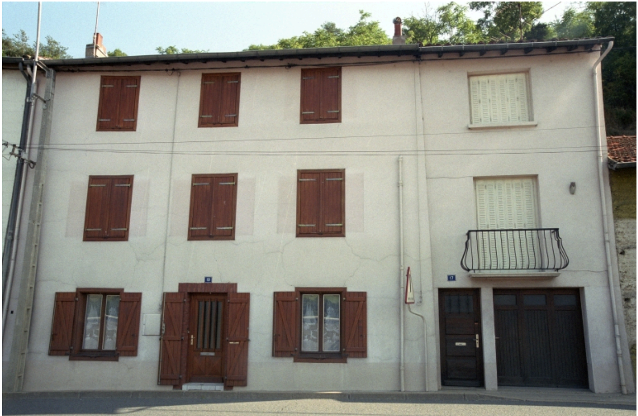
Boën, îlot 20, RN 89, 19 et 17. Vue générale de la façade sur rue.
