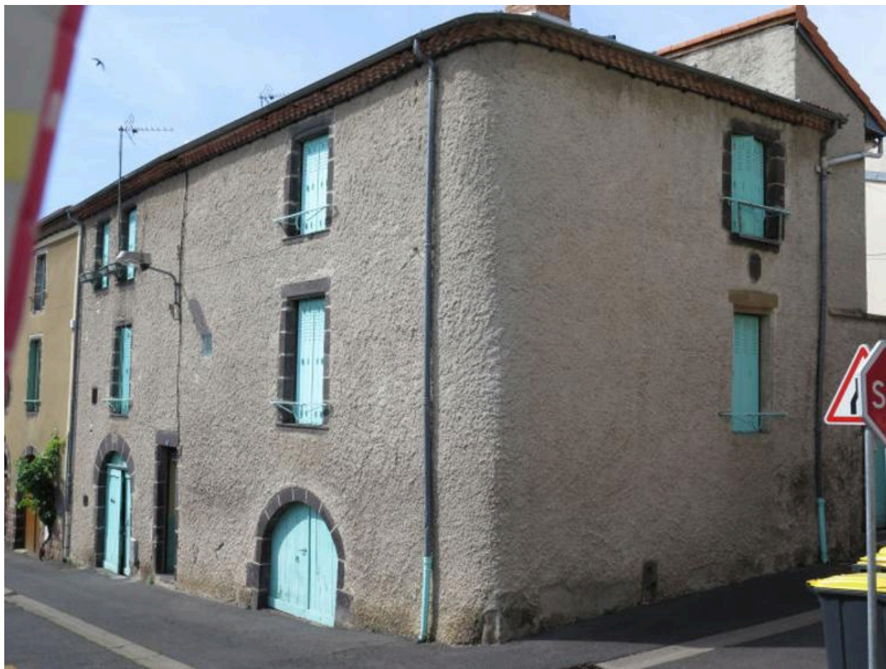
Type massé avec parti d'élévation à travées (Cournon, 13 rue de la Treille)
