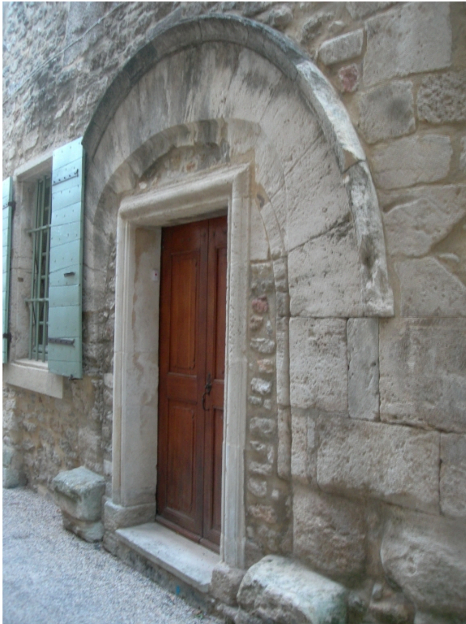
Façade sur rue, porte d'entrée (sur parcelle D 195).
