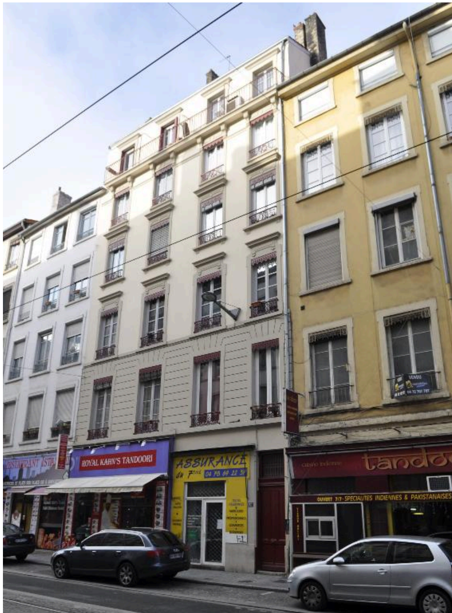
Vue générale de l'élévation sur rue
