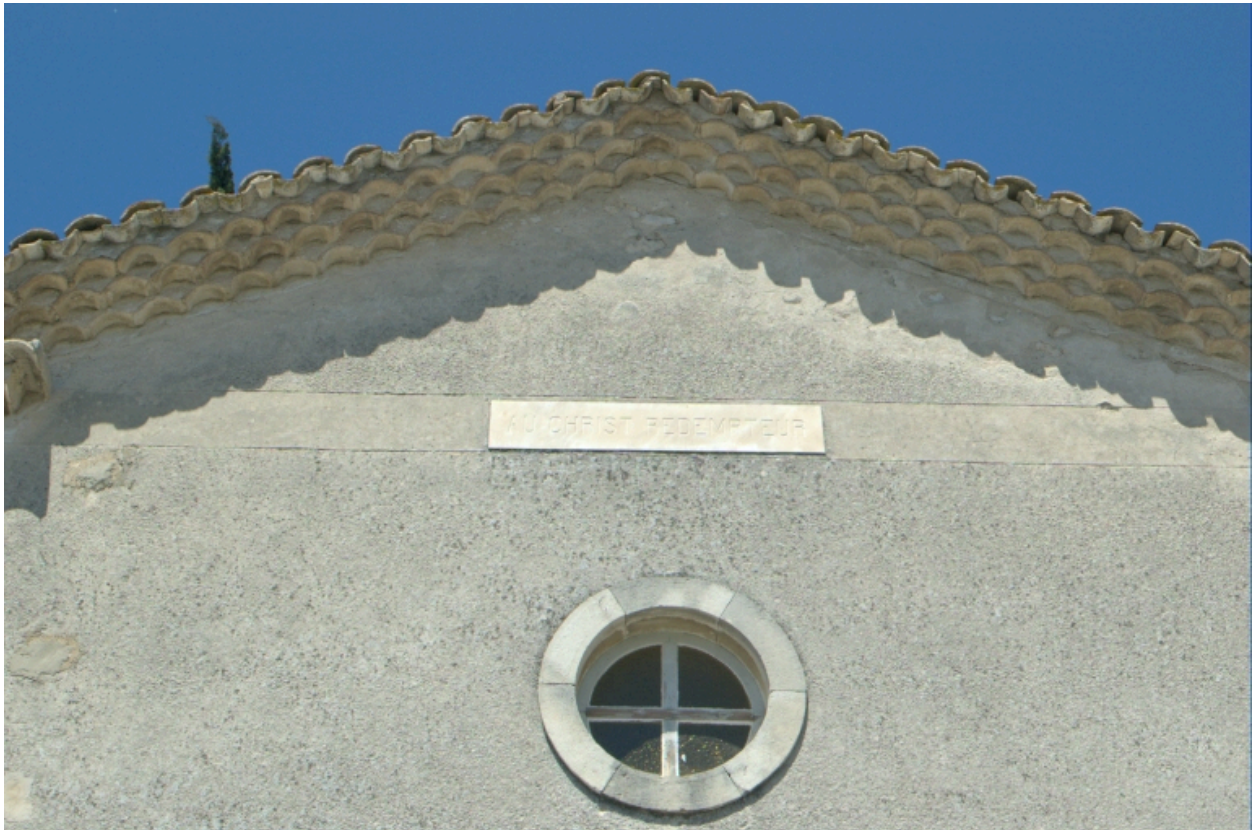
Détail de la façade : oculus surmonté de l'inscription Au Christ Rédempteur.
