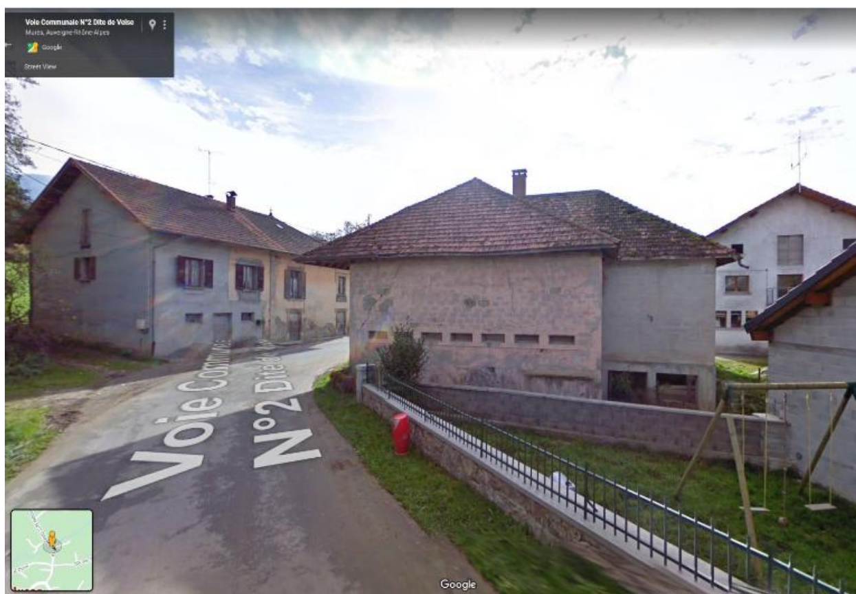
Vue de la fruitière en 2010, depuis le nord-ouest (couverture photographique Google Maps).
