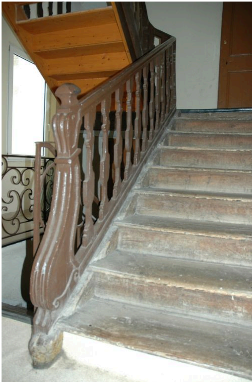
Deuxième volée de l'escalier en bois, rampe en bois découpé.
